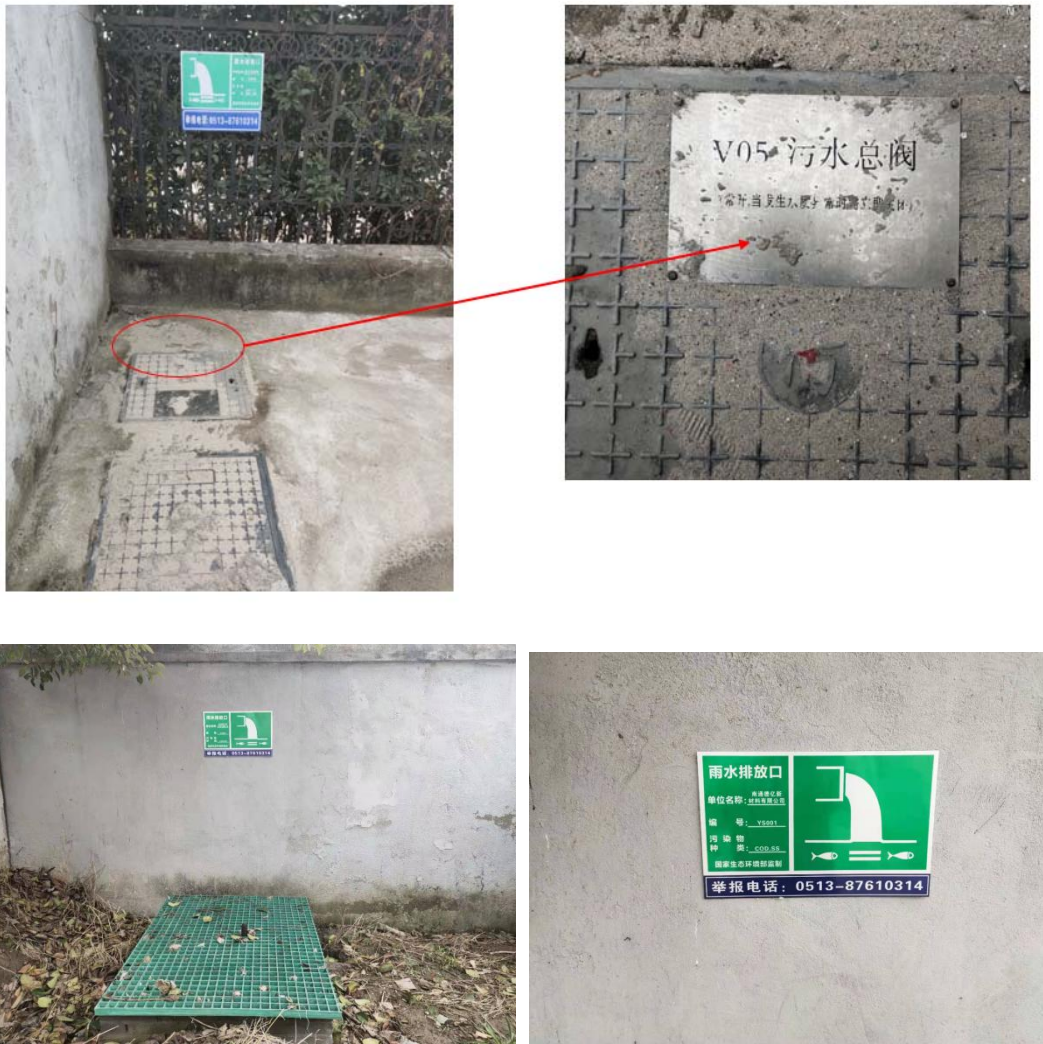
图 4-25 项目污水排口及雨水排口切断阀门现状图
