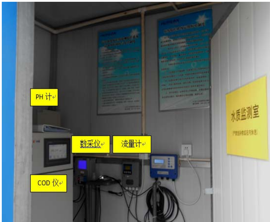
图 4-28 废水在线监测设备
