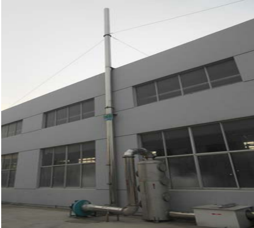
图 4-27 项目 2#排气筒现状图
