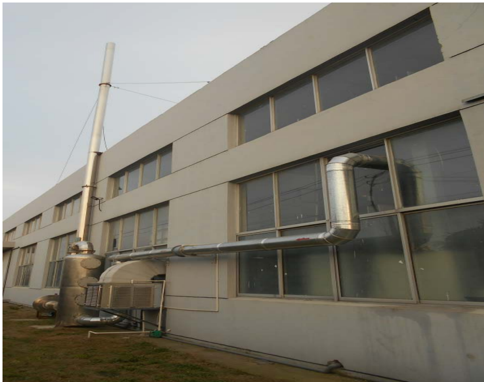
图 4-26 项目 1#排气筒现状图
