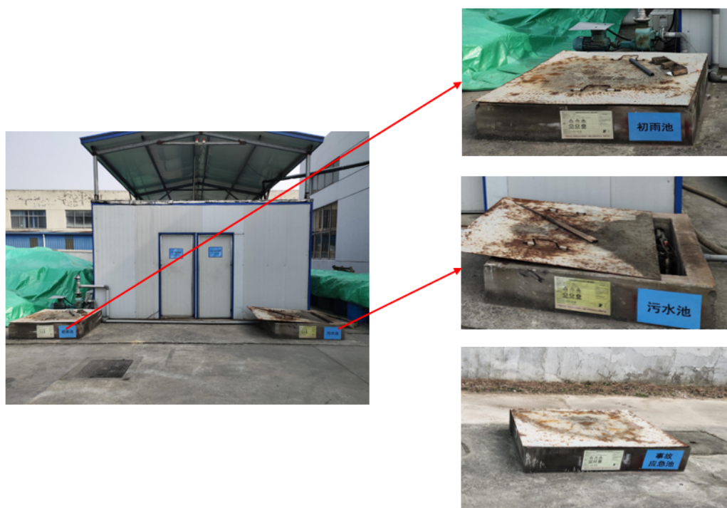
图 4-24 事故应急池、初期雨水池
