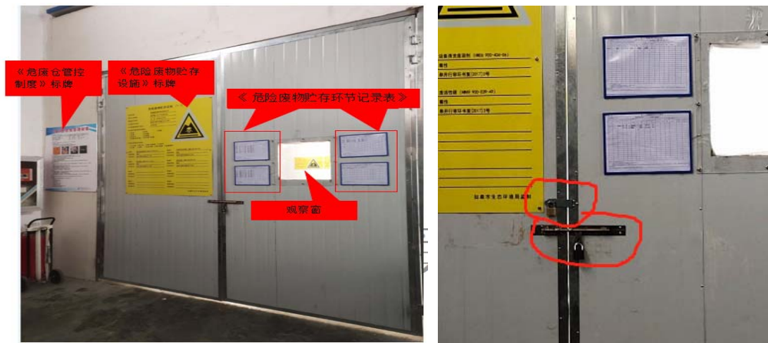
图 4-15 项目危废仓库大门双锁和观察窗图
